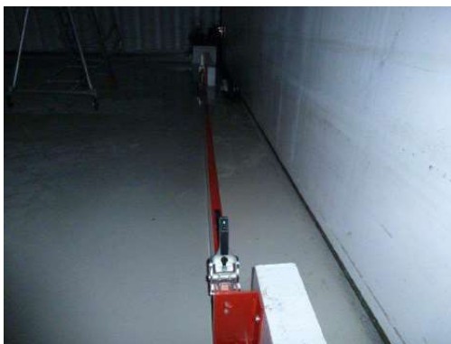
Figure 3 : Barrière étanche amovible mise en place au niveau de la porte d'accès principale de la hangarette 0086 (HG7) [photo ESID]
