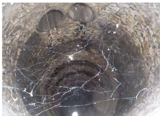
Figure 25 : Puisard d'infiltration [Setec Hydratec]
