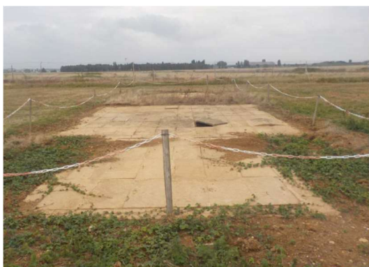
Figure 24 : Décanteur au 1 er plan et puisard au 2 e plan [Setec Hydratec]
