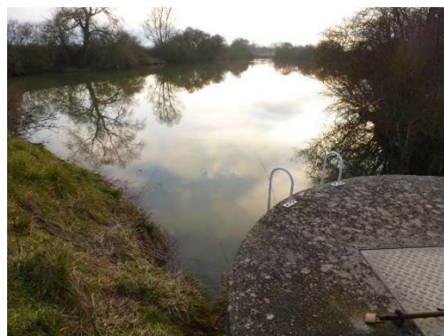
Figure 18 : Étangs de Jallans au niveau du poste de refoulement [ESID]
